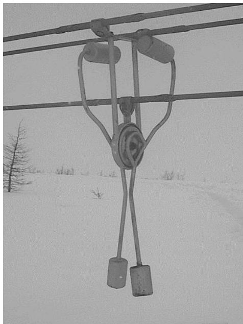
Рис. 1. Образец комбинированного гасителя колебаний
