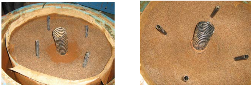
Рис. 6. Прифильтровая зона скважины до и после регенерации
